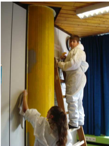
Erst nach dem Abkleben und Grundieren darf mit dem eigentlichen Streichen begonnen werden...
